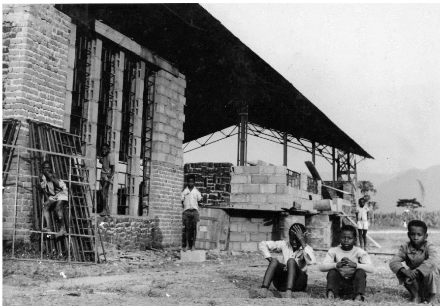
Baraka febbraio 1964 Bambini davanti al cantiere della nuova chiesa
