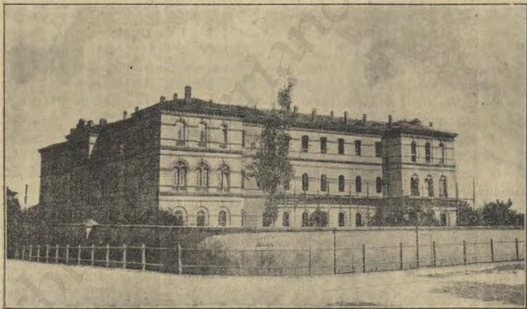
PARMA - Istituto Missioni Estere - Stato del nuovo fabbricato al 1.º Agosto 1921.
