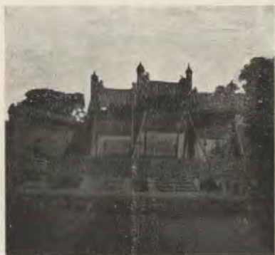
(Fig. 35) — Mien-tce — Entrata di una pagoda in riparazione. (fot. P. Bertogalli).
