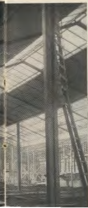
IL MONTAGGIO DEI PADIGLIONI DELLA ESPOSIZIONE
