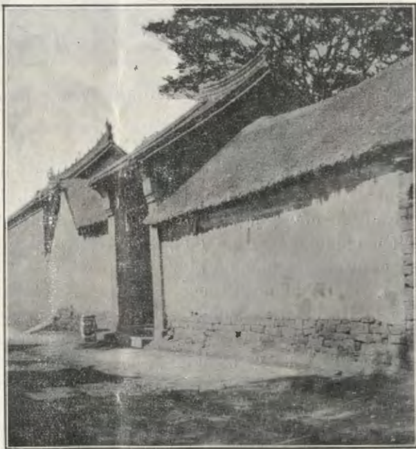
Residenza di Hsiang-hsien. — Come era la facciata d'ingresso nel 1907. (fot. P. Bonardi).
