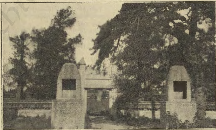
Cina - Tien-shen-tan. - Altari della pioggia e del vento.
