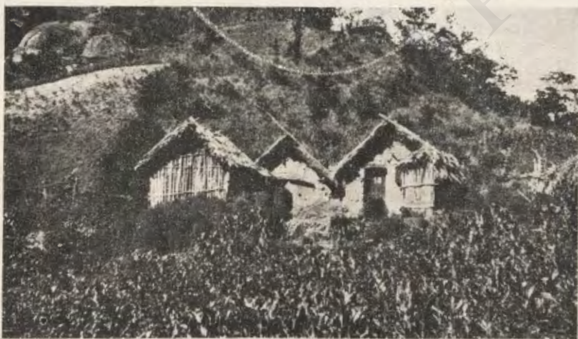
Honanjü - Sui monti - Le Capanne-residenza.
