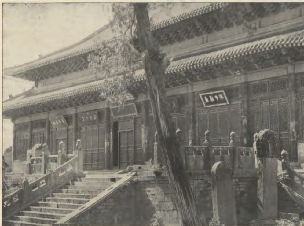
CINA: Padiglione centrale di Tung-wan-miao. — E' stato restaurato da poche decine di anni. Una spesa colossale! Non si capisce come si lasci andare in rovina tutto il resto della vastissima pagoda. Padiglioni, archi, chioschi, idoli, non sono più che una triste collezione di ruderi.
