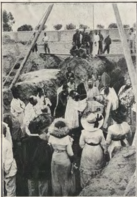
CHENGCHOW. — Posa della prima pietra dell'Orfanotrofio Italiano. La pietra benedetta al comando del R. P. Armeloni discende nelle fondamenta. (fot. del F. D. Guareschi).
