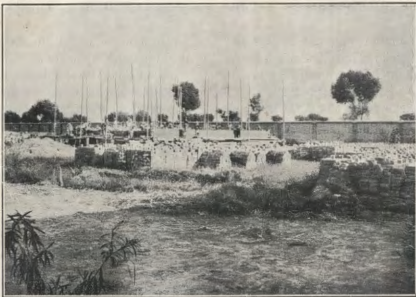
CHENGCHOW. — Orfanotrofo Italiano. — Costruzione del Padiglione per le suore.
