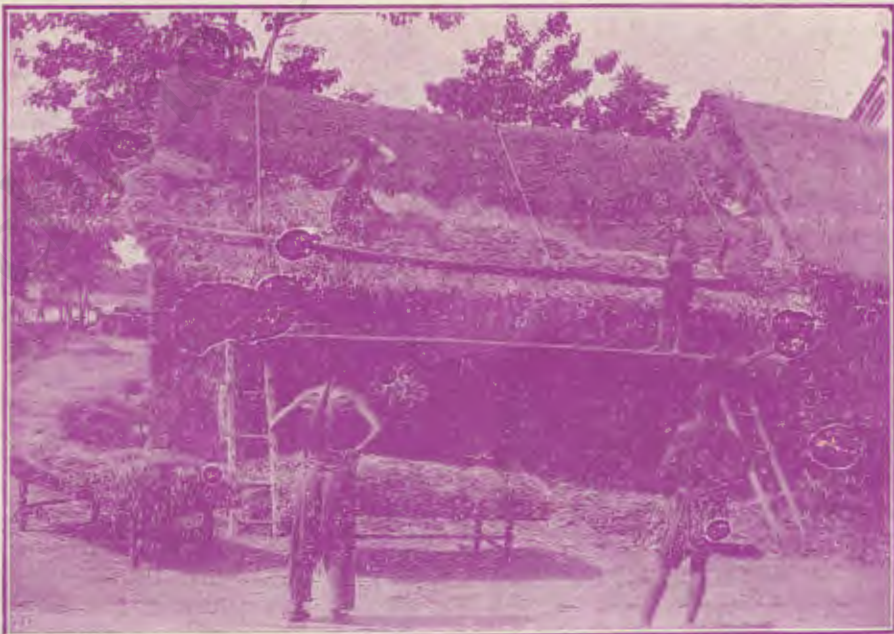
(Fig. 4) — Quanto poco ci vuole per fare una casa. — Il tetto di paglia di una casa riparato dopo parecchi anni di servizio. ( fol. P. Guareschi ).
