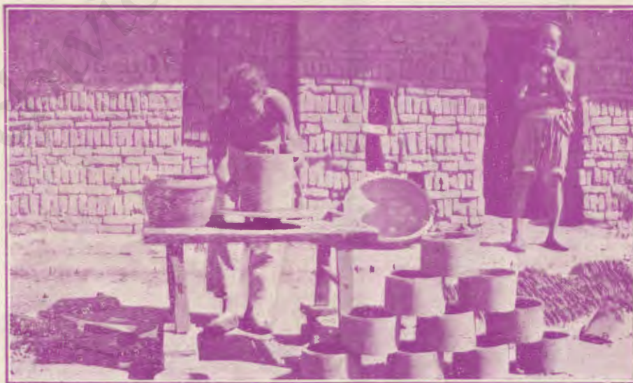
(Fig. 2) — Quanto poco ci vuole per fare una casa. — Operai che fanno tegole. (fot. P. Guareschi).
