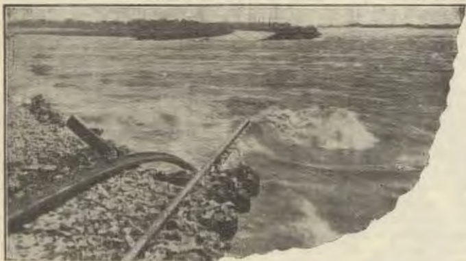
La linea ferroviaria demolita dalla piena.
