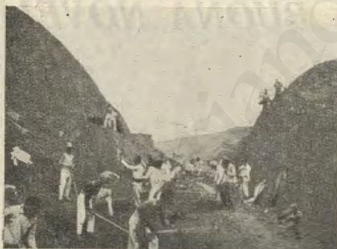
LOYANG. - I lavori della ferrovia.
