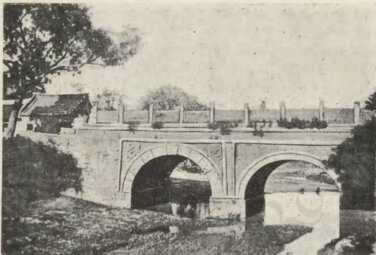
In Missione - CHENG-CHOW - Il ponte a sud della città sulla via che porta alla missione.
