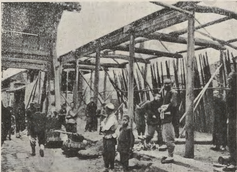
Una casa cinese in costruzione.
