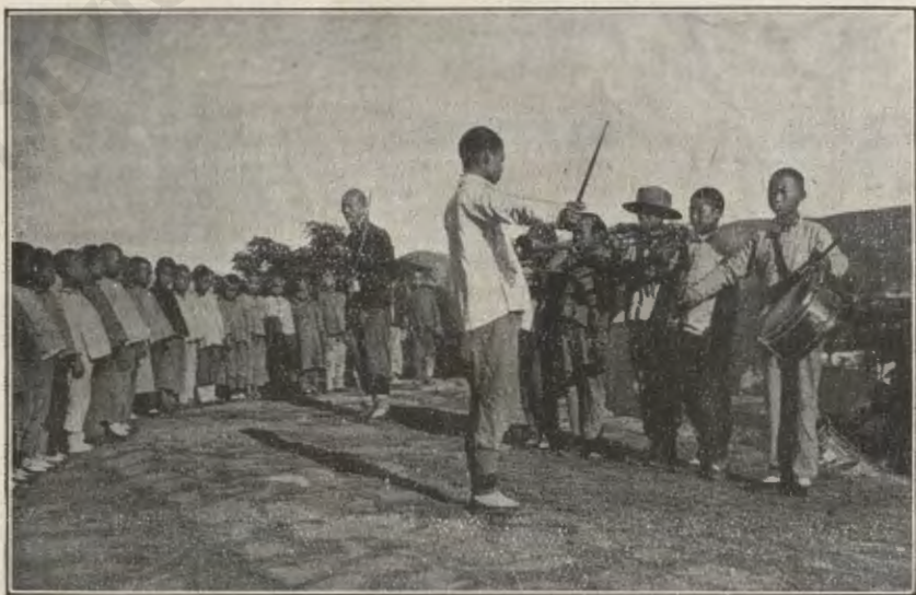
Scuola Elementare — Fanfara della Scuola di Yung-Yang.
