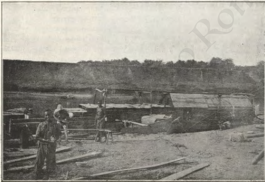
Lungo il fiume Zou. — Barche in riparazione nel porto di San-ly-ho. (fot. P. E. Bertogalli).
