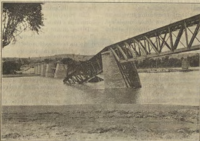
Un ponte fuori servizio.
