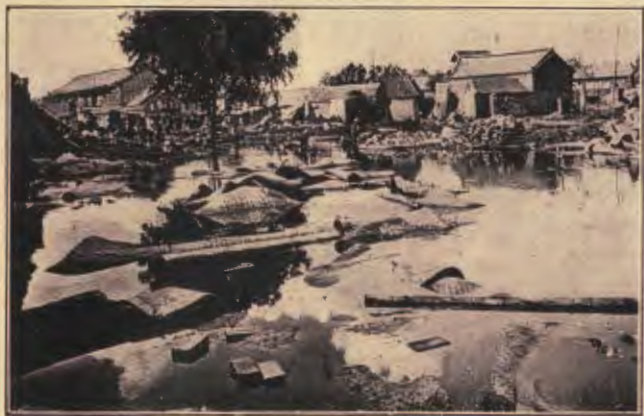
Capanne e magazzini distrutti dall'inondazione.
