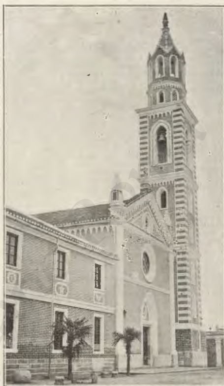
(Fig. 78) — Il B. Perboyre e Marco Polo — « Alla chiesetta gotica è stato aggiunto un altissimo campanile che è certo uno dei più eleganti di tutta la Cina ». ( fol. P. C. Silvestri ).
