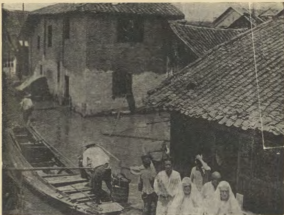
Le recenti inondazioni in Cina. — Nella città di Hwangchow, che si trova sulle rive del fiume Azzurro ad oriente e non molto lontano da Hankow, che come si sa fu il centro principale delle recenti inondazioni, le Suore Francescane Missionarie di Maria lasciano la loro chiesa e, traversando in barca le vie inondate della città, si recano all'ospedale per curare le numerose vittime della catastrofe senza precedenti. (Fides-Foto).
