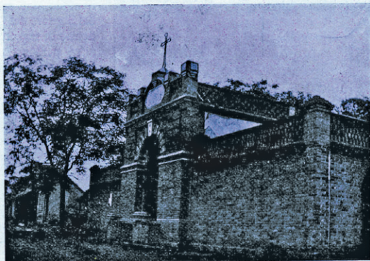
(Honan Occid.) LU-SHAN — Ingresso della Residenza.
