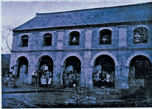
(Honan Occid.) HSIANG-HSIEH — L'edificio della scuola femminile.
