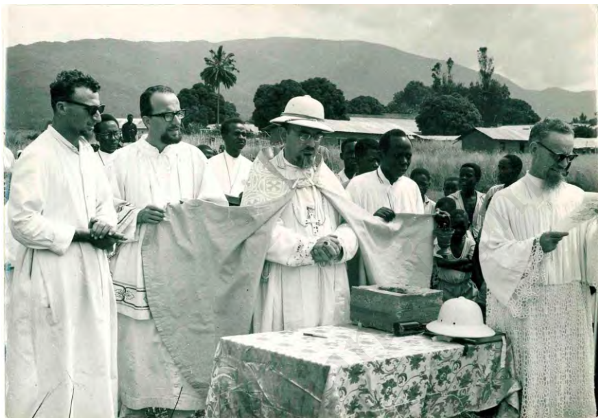
Baraka, 23 mai 1963 (Sacré Cœur de Marie): pose de la 1 ère pierre de l'église, avec Faccin, Sartorio, Catarzi, Tomaselli et des Frères Joséphites du Rwanda.
