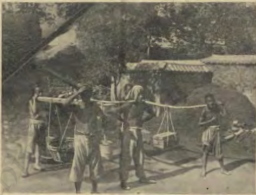
Operai che trasportano materiali da costruzione.
