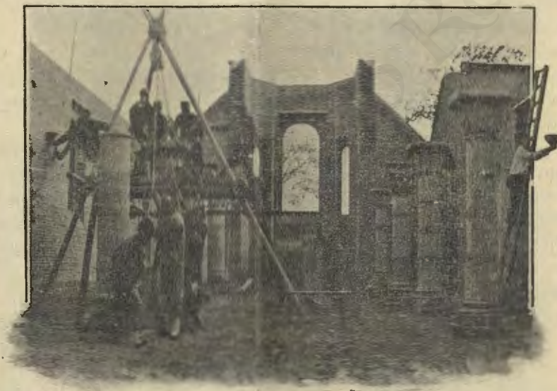
(HONAN OCCID.) — La Chiesa di Hsiang-hsien in costruzione.
