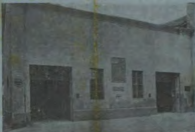
Facciata esterna del Garage
