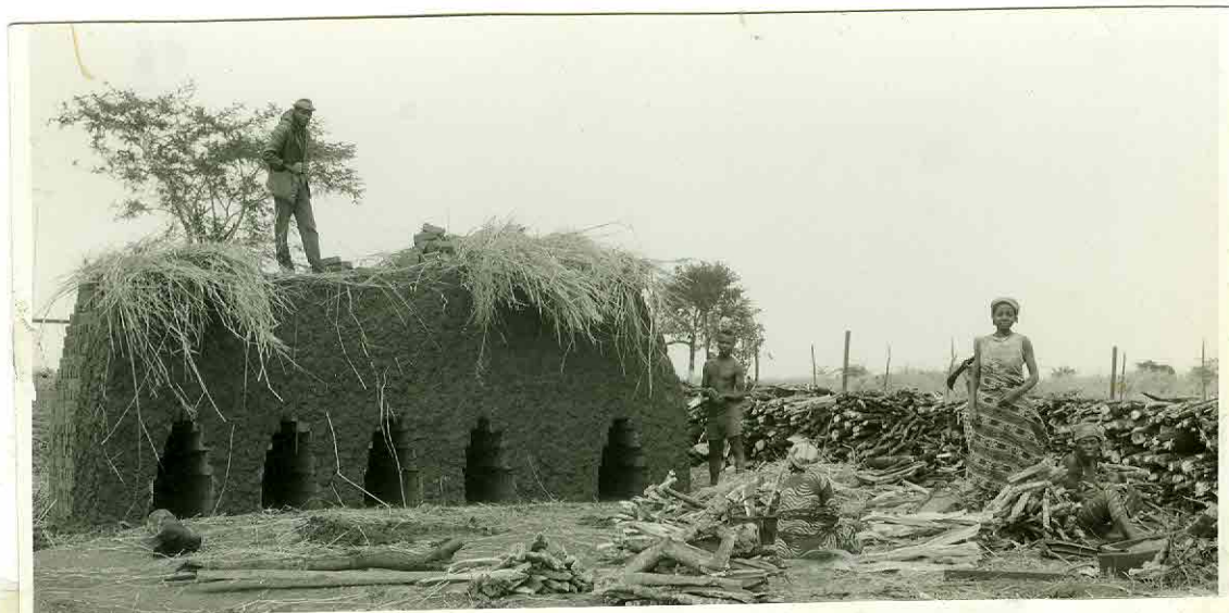
Fizi: la foto è postuma, ma il costruttore del forno dei mattoni è lo stesso, Paul Aubiens, che ha preparato i forni di P. Giovanni. Quello nella foto è il secondo dei sette forni della "ricostruzione".
