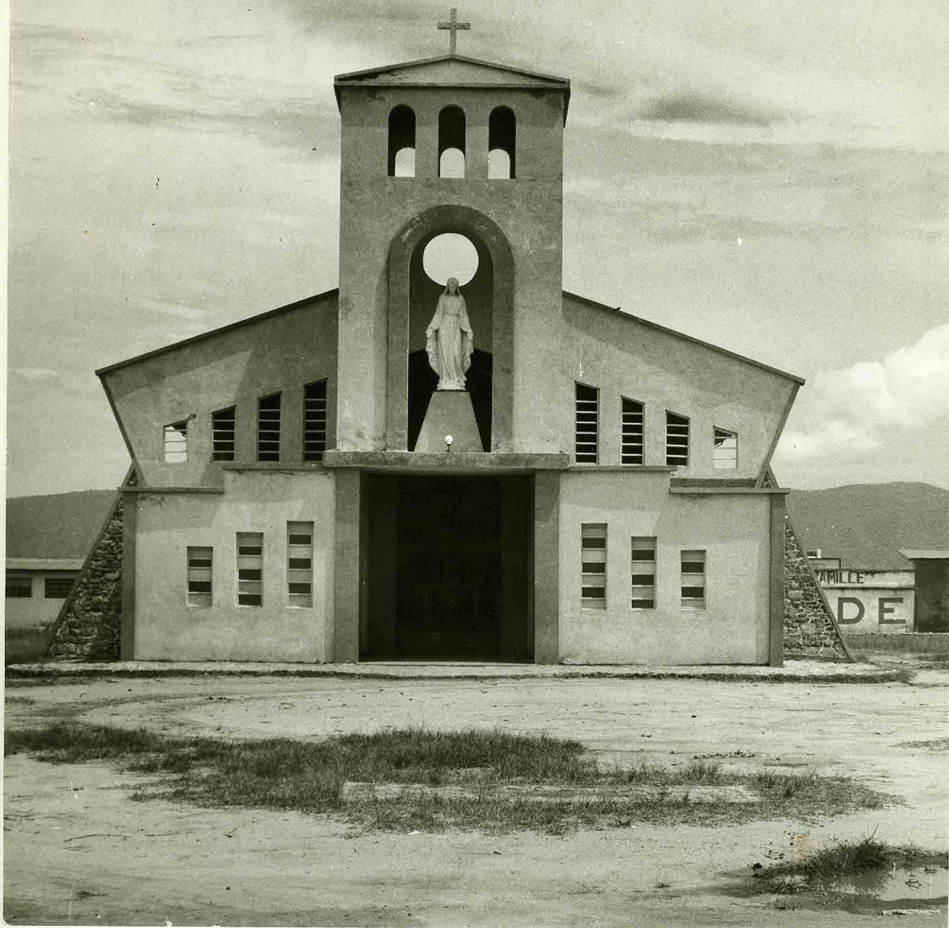
Baraka: La chiesa cominciata da fratel Vittorio Faccin nel maggio del 63 (posa della prima pietra), è portata a termine nel 1967 da fratel Mariano Masolo che, dopo aver riparato i danni causati dalle azioni di guerra, ha eretto davanti all'angar l'attuale facciata semplice ed elegante.
