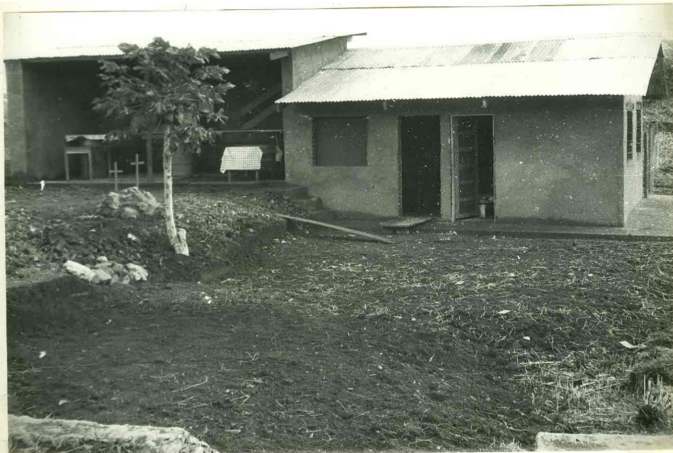
La casetta di Fizi ricostruita da P.Cima, sulle fondamenta della casetta prefabbricata di P.Giovanni.
