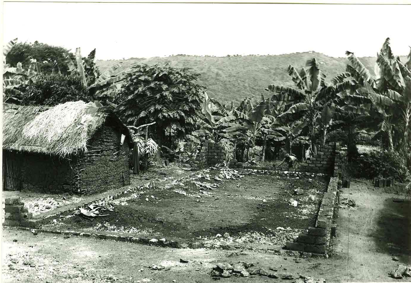
Fondamenta per una nuova casa a Buzimba.
