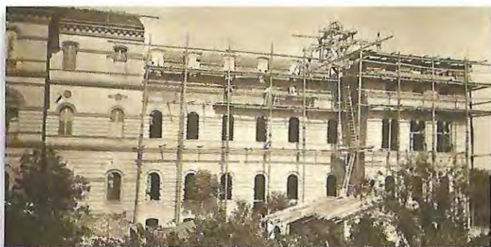
1921 : La construction du coté ouest de l'Institut
