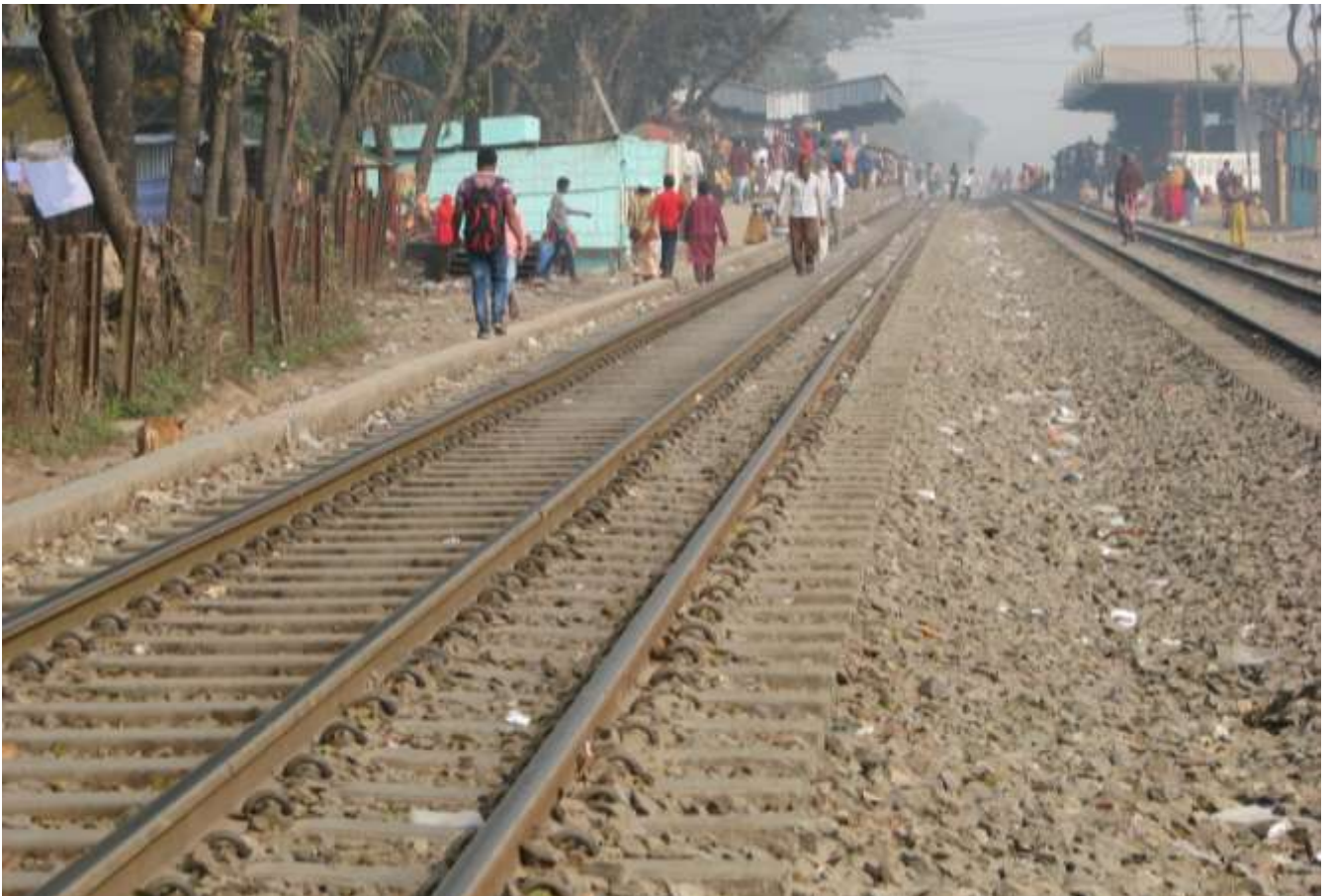
La ferrovia a tre binari, per renderla transitabile con treni a scartamento ridotto e normale.
