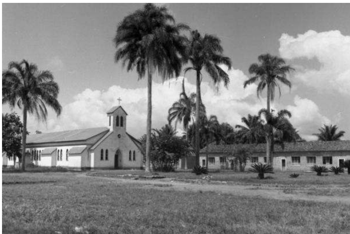
1974 Mungombe: église et séminaire
